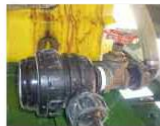
El dispositivo de aislamiento del filtro nos permite operar en él con el depósito lleno sin problemas de derrame de agua
