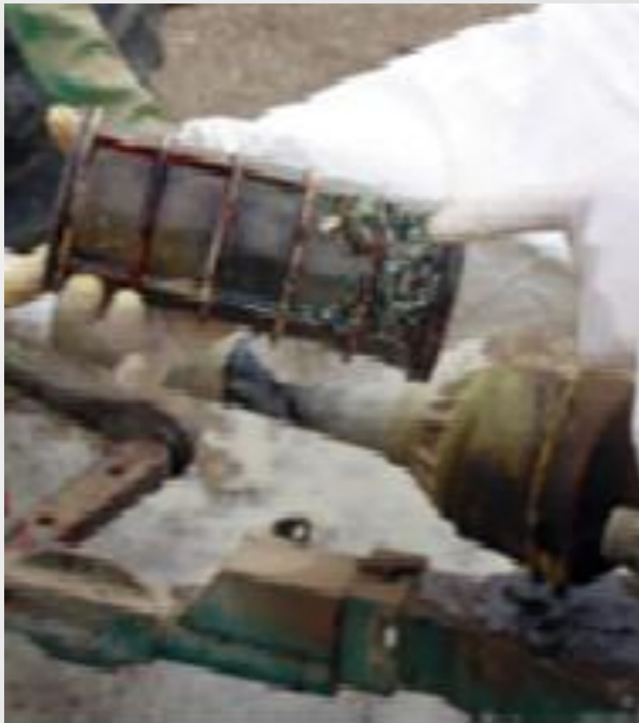
Filtro obstruidas por suciedad
