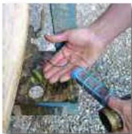
El filtro es correcto pero aparecen problemas graves en las juntas o su estado denota falta de limpieza
